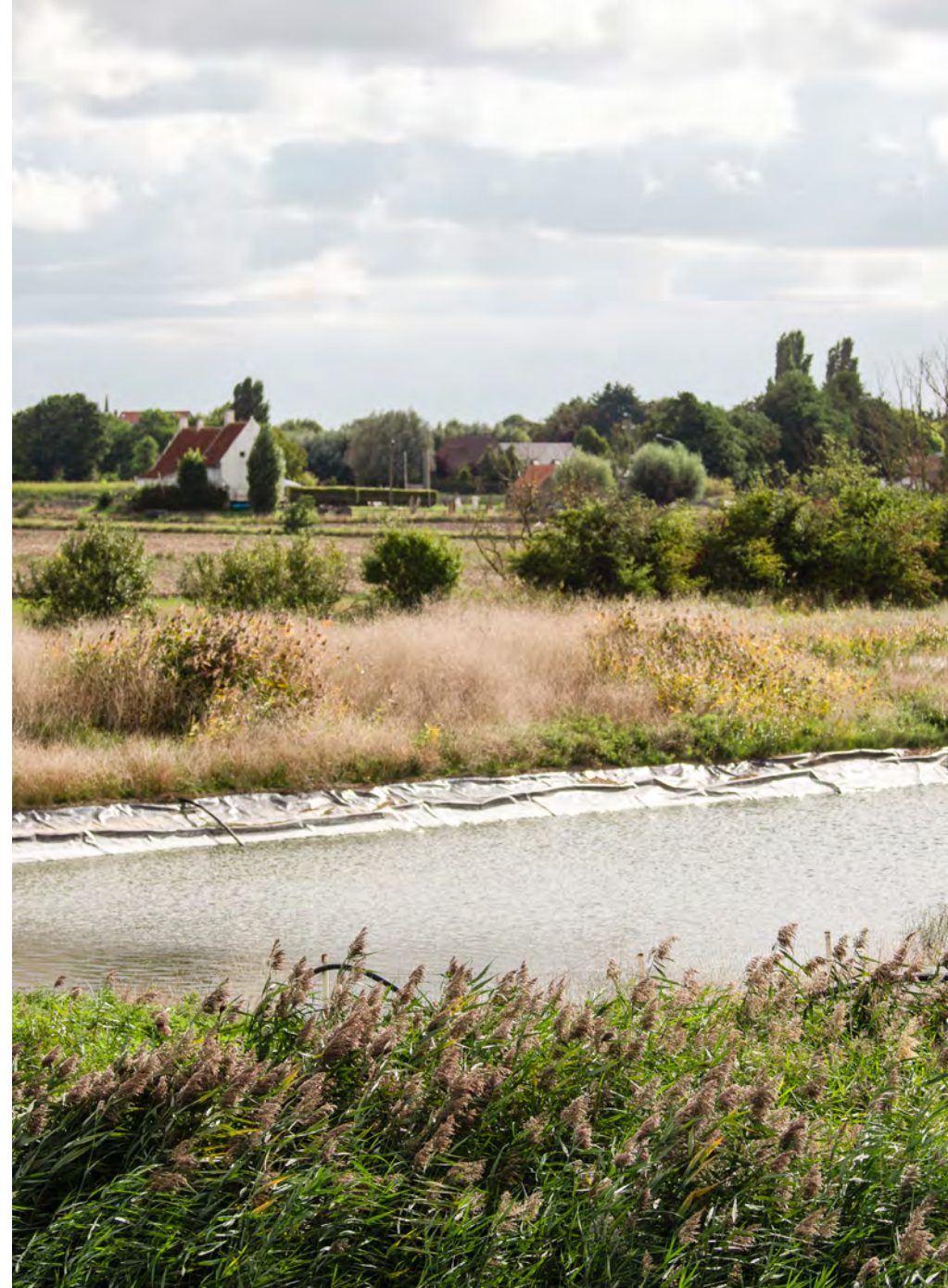
Foliebassin zonder taluds, beter geïntregeerd in het landschap. © Boerenbond.
